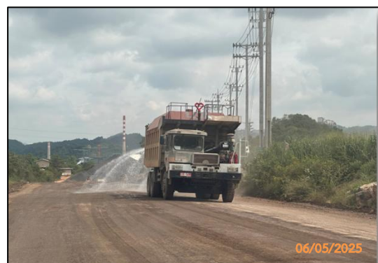
รูปที่ 2-51 การฉีดพรมน้ำบริเวณกองหินก่อนทำการตักขน
